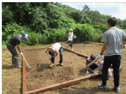
【テントサイト設置 7/3】
